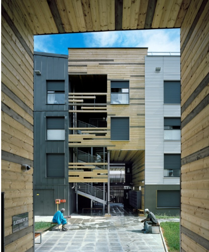
Montreuil Brulefer_120 logements_ Livraison 2019
