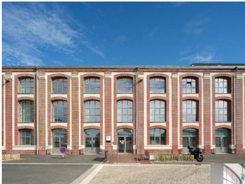
Reconversion de BUDDICUM, SOTTEVILLE LES ROUEN, 6 500 m 2 de halle industrielle transformée en Campus tertiaire
